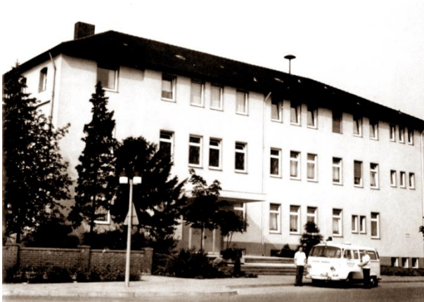
Eine Fotografie aus dem Band „Verl – unsere Gemeinde“ von Friedrich Adämmer und Udo Graffunder mit der Eingangsseite des Hospitals nach dem Umbau.
