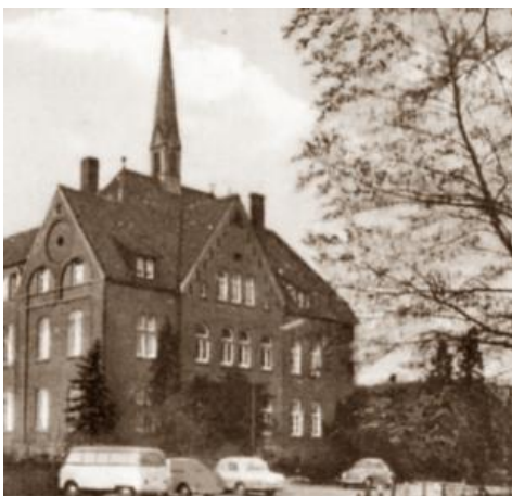
Der Ausschnitt aus einer Ansichtskarte zeigt die Eingangsseite des St.-Anna-Hospitals vor dem Umbau.
