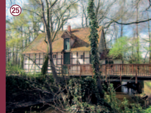
25 Die Bunten Mühle am Oelbach ist ein zweigeschossiges Fachwerkgebäude mit Satteldach, erbaut 1832, mit intakter Mühlenanlage, stillgelegt 1975.
