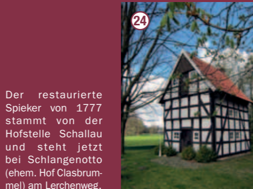
24 Der restaurierte Spieker von 1777 stammt von der Hofstelle Schallau und steht jetzt bei Schlangenotto (ehem. Hof Clasbrummel) am Lerchenweg.
