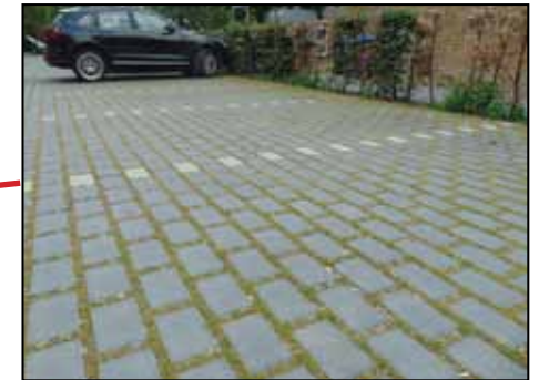
Abb.15.: Beispiel PKW - Stellplätze aus Fugenpflaster (Büro Wolf, 2020)
