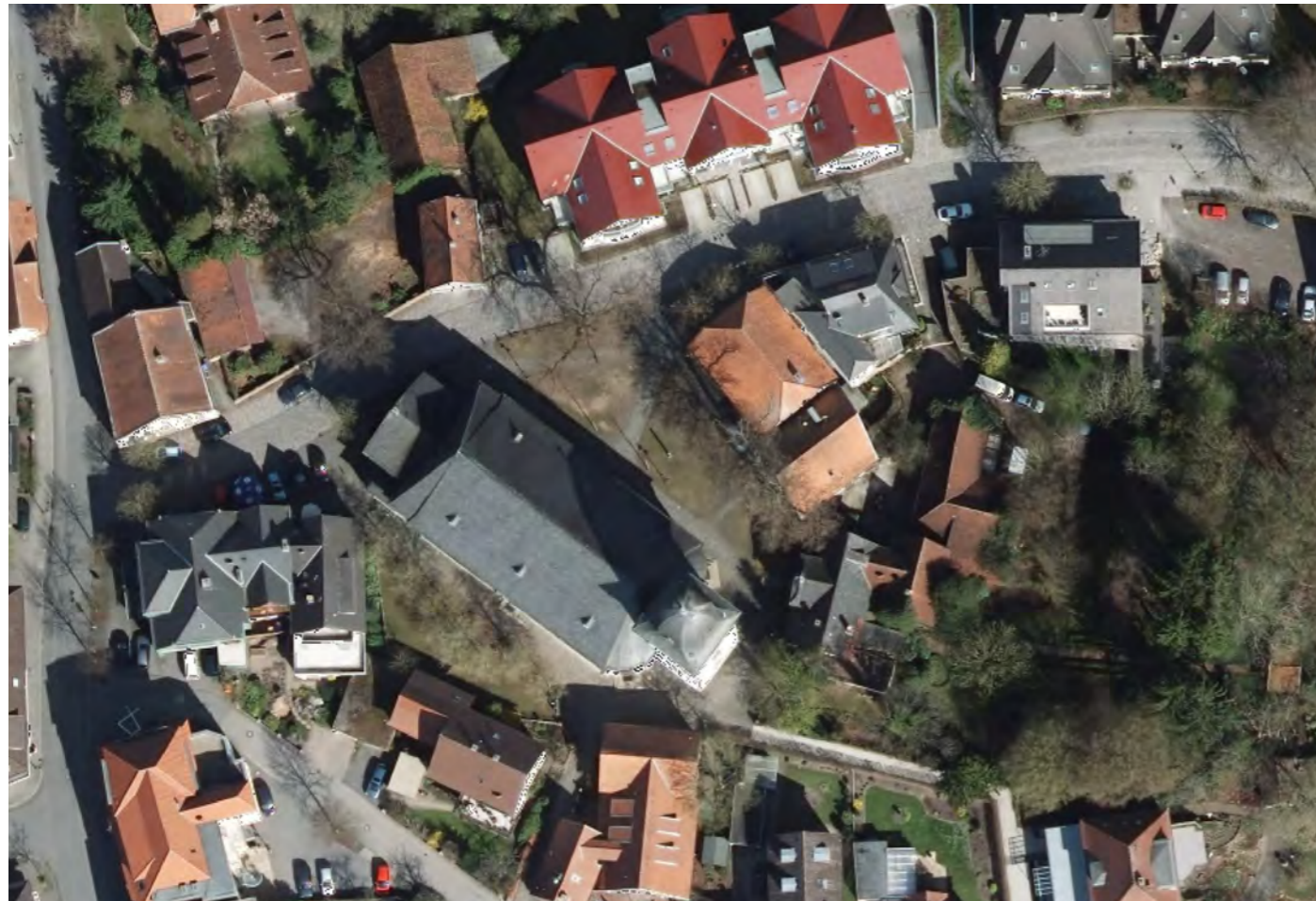
Bestandsituation Kirchplatz St. Anna Luftbild
