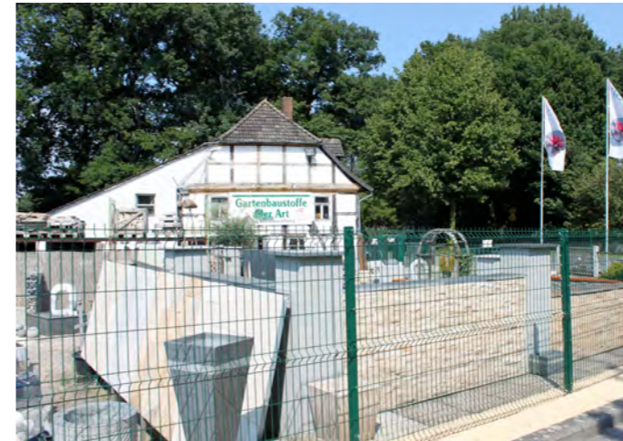
Bestand - Ortseingang Dorfmuhle, Vorplatz Baustoffhandel
