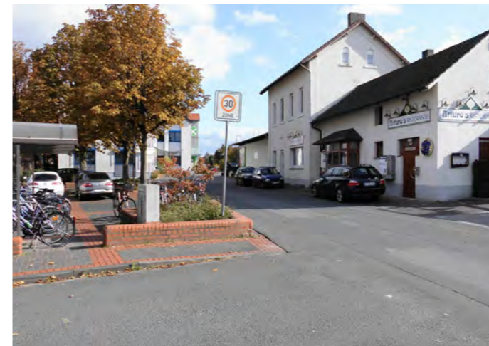
Bestand - Altes Bahnhofsgebäude
