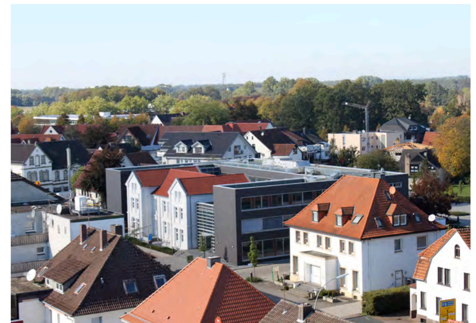
Bestandsituation Blick auf das neue Rathaus
