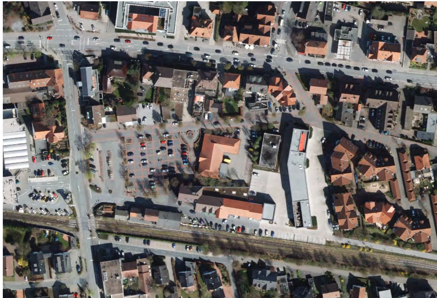
Bestandsituation Marktplace / Neues Feuerwehrhaus Verl Luftbild
