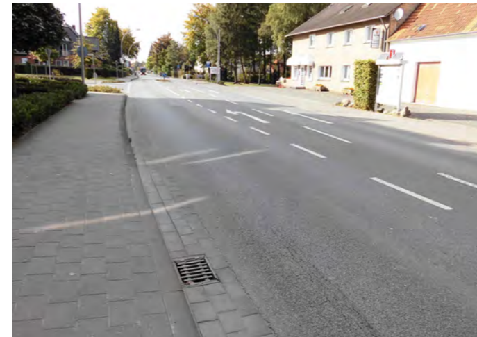
Bestand - Paderborner Straße
