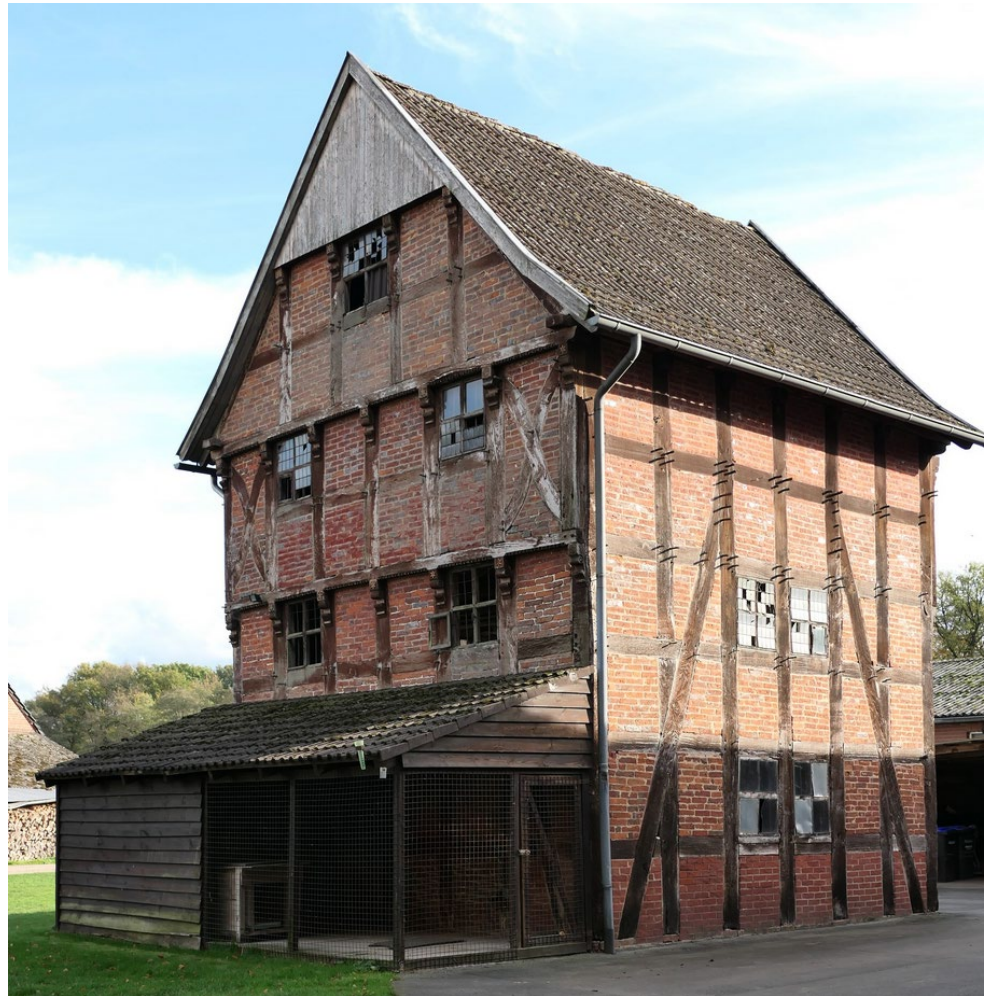
Speicher, Wapelweg 45 erbaut 1747
