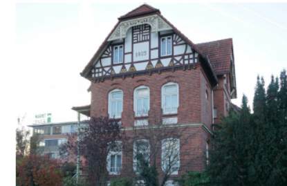
Abb. 2 | Wohngebäude, Bahnhofstraße 6 am 16.12.2022
