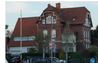
Abb. 3 | Wohngebäude, Bahnhofstraße 6 am 16.12.2022
