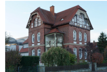
Abb. 1 | Wohngebäude, Bahnhofstraße 6 am 16.12.2022
