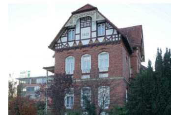
Abb. 2 | Wohngebäude, Bahnhofstraße 6 am 16.12.2022
