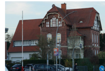
Abb. 3 | Wohngebäude, Bahnhofstraße 6 am 16.12.2022
